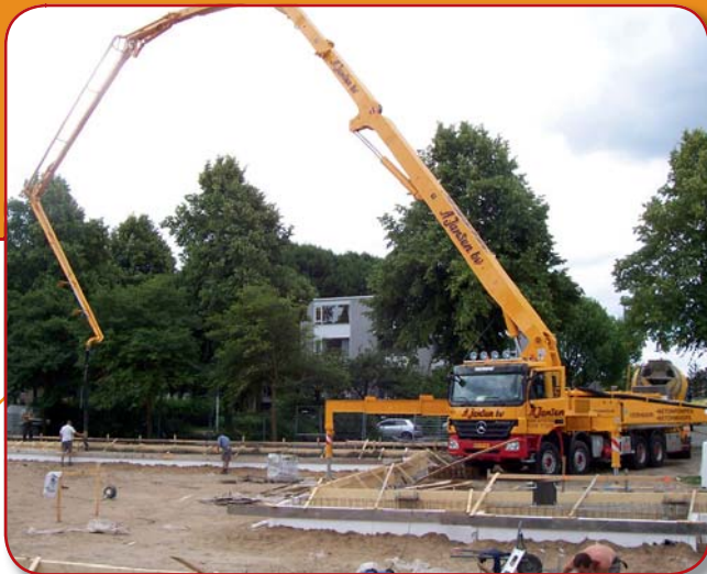
De nieuwe 52 meter betonpomp op locatie
