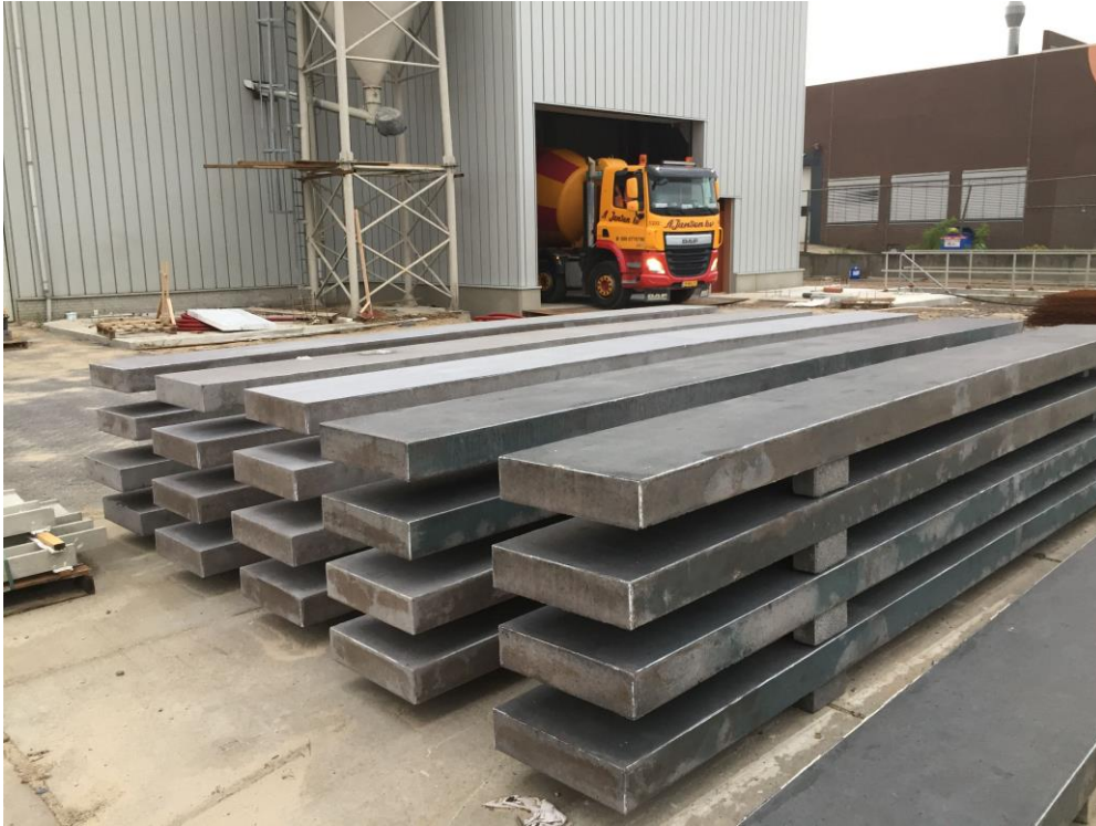
Opslag van de Geopolymeer brugdelen bij Van Riel in Uden
